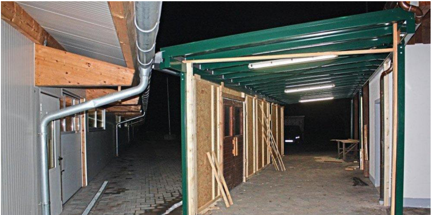
Noch eine Baustelle, aber vom 3. bis 6. Januar Aufenthaltsort von Bayerns und Deutschlands besten Weitenjägern. Für die BM und DM des publikumsträchtigen Eisstock-Weitschießens wird das im Sommer vergangenen Jahres für 18000 Euro montierte Vordach komplett eingehaust und bietet dann bis zu 90 Personen Platz. –Foto: Kamhuber
